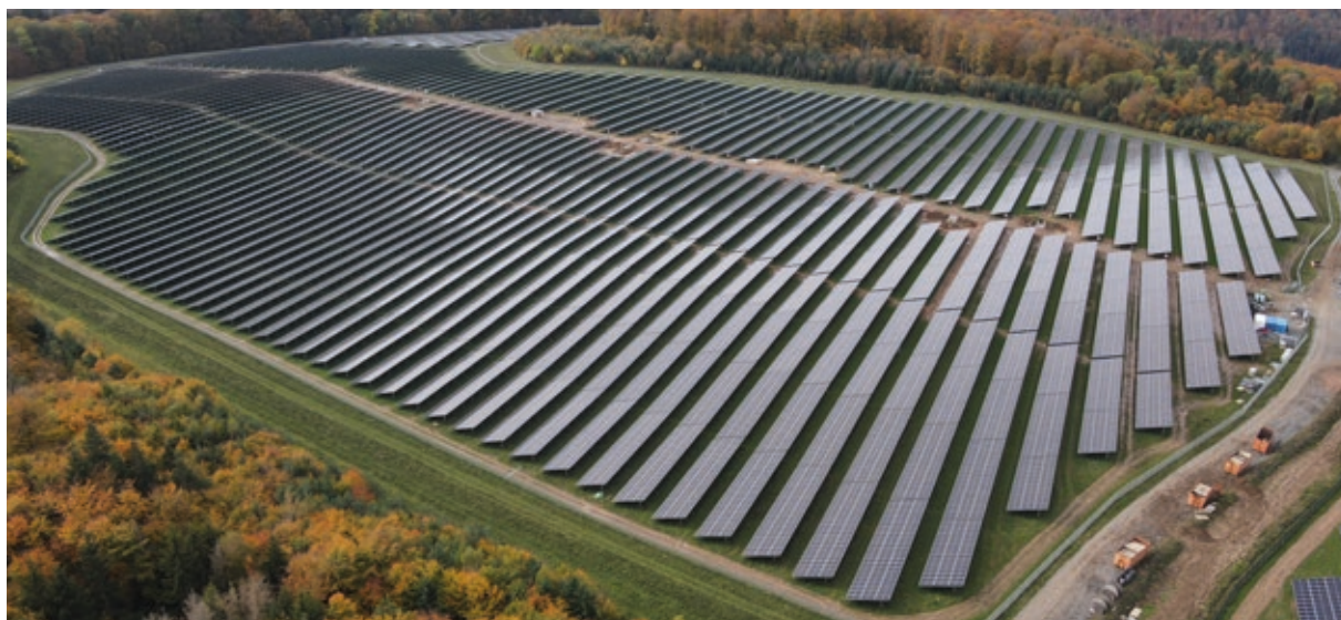
PV-Fläche in Gickelfeld mit einer Gesamtfläche von 65 ha
