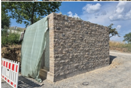
Der erste Bauabschnitt bei Stuppach ist so gut wie abgeschlossen. So wurde unter anderem das Abgabebauwerk in Stuppach mit Natursteinen verkleidet.
