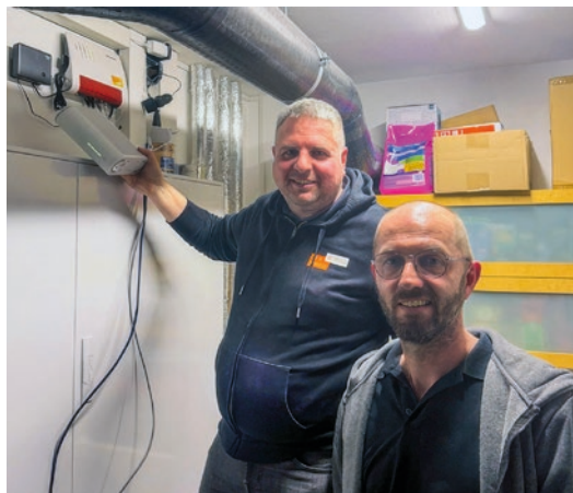
Matthias Siegel (Leiter Telekommunikation) beim Einrichten des 10G-fähigen Glasfaseranschlusses beim Kunden.
