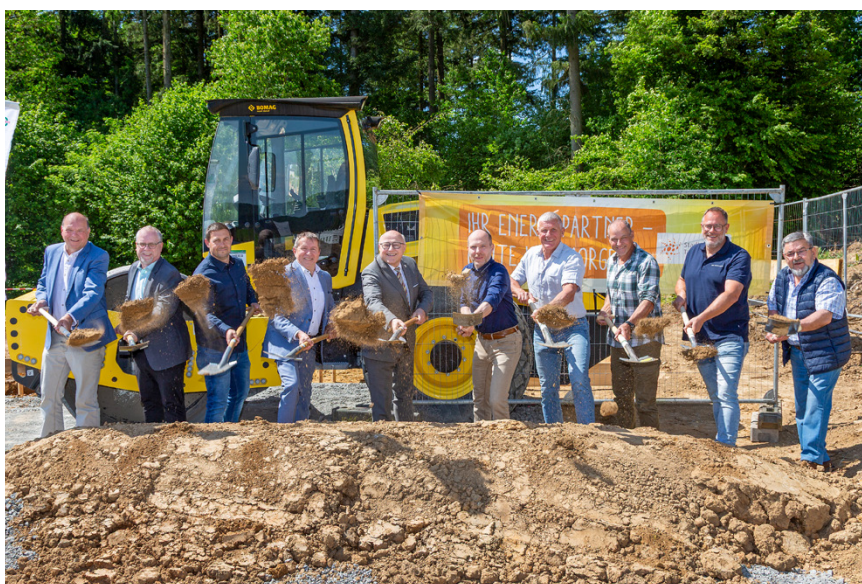
Spatenstich für die neue Wasserkonzeption. Von links: Wolfgang Herz (Aufsichtsrat Stadtwerk Tauberfranken), Erwin Landwehr (OV Stuppach), Wolfgang Walter (Leiter Wasserversorgung Stadtwerk Tauberfranken), Paul Gehrig (Geschäftsführer Stadtwerk Tauberfranken), Oberbürgermeister Udo Glatthaar, Tobias Schneider (Geschäftsführer ARZ Ingenieure), Andreas Bokmeier (Geschäftsführer Anton Bokmeier GmbH), Stefan Porasil (Geschäftsführer Anton Bokmeier GmbH), Stephan Christ (Bauleiter ARZ Ingenieure) und Josef Wülk (Aufsichtsrat Stadtwerk Tauberfranken). Foto: Besserer
